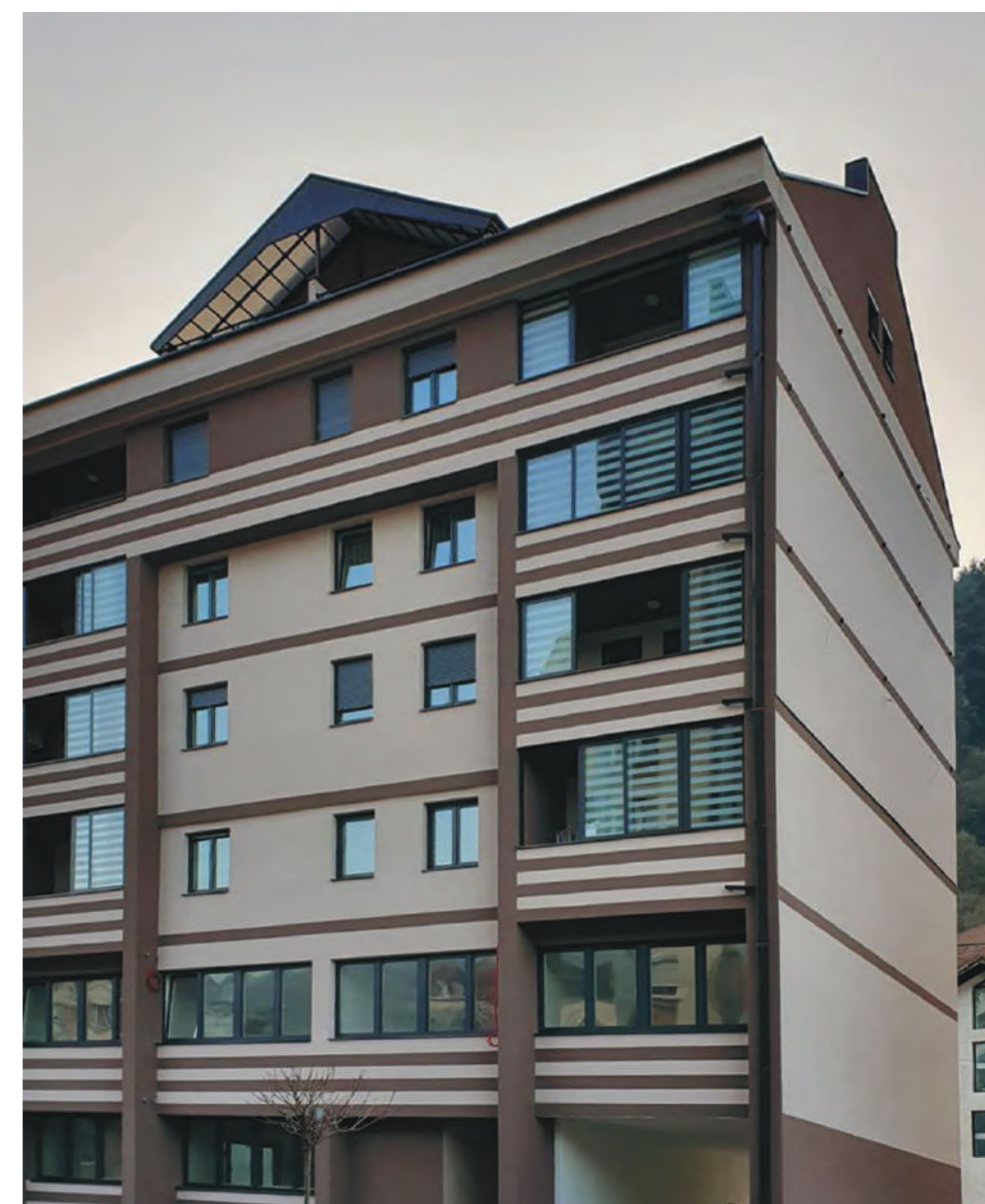
Stambena zgrada, Zvornik
